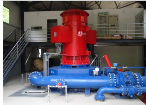
Турбины Пелтона подходят для высоких напоров и малых потоков и с широким спектром соответствующих конфигураций. Siapro использует стандартизированный производственный процесс для обеспечения высокого качества конечного продукта. Предлагаем консалтинговые, инженеринговые услуги, производство и реализацию.
