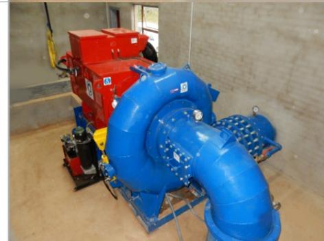
Мы проектируем вертикальные и горизонтальные турбины Фрэнсиса с номинальной мощностью до 10 МВт. С достижением эффективности турбин более 93%, Турбины Фрэнсиса являются наиболее широко используемыми.
