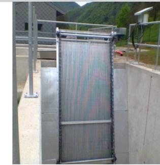
Siapro предоставляет все гидро оборудование, например, грубые и мелкие сетки различных конфигурации. Грубая сетка устанавливается в начале ГЭС как средство удаления крупного мусора: камней, веток и деревьев и т. д.
